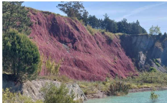
Aspeto final do talude
