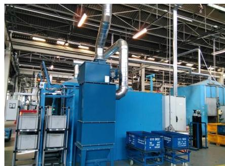
**Figura 44 - Sistemas de filtração de extrações de soldadura 1, 2, 3 e 4.**
