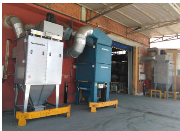
Figura 42 - Sistemas de filtragem de extrações de soldadura 1, 2, 3 e 4.
