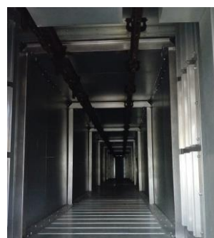
Figura 66 - Novo forno elétrico instalado na Pintura.
