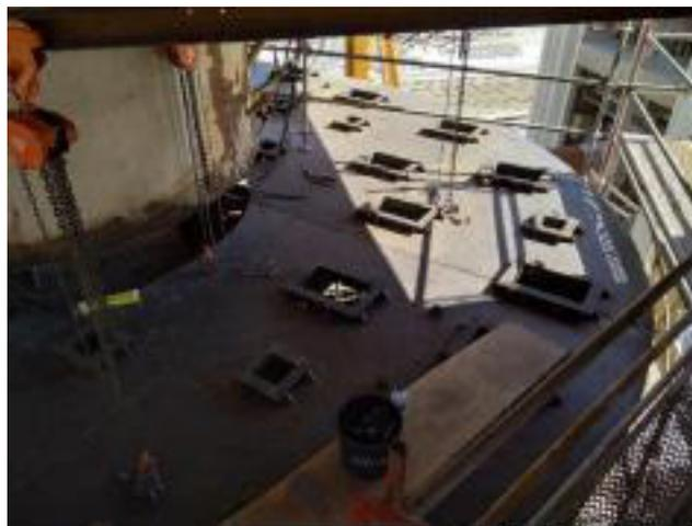
Modificação do revestimento metálico do teto do ciclone 5 da torre de pré-aquecimento do forno 7 que incluiu uma nova solução modular de tijolos refratários
