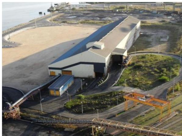
Armazém fechado de coque de petróleo (MTD 14.i), com capacidade para 10 000 t, dispoendo também de sistemas de despoeiramento com filtros de mangas associados (MTD 14.h) e que permitiu a desativação da armazenagem em pilhas a céu aberto no período 2005-2007 (MTD 15.b)
