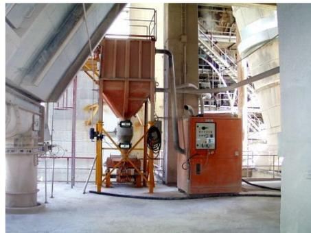
Sistema de aspiração fixa centralizada para apoio às operações de limpeza no edifício da moagem de cru da linha 6 (MTD 14.g e MTD 29.a)
