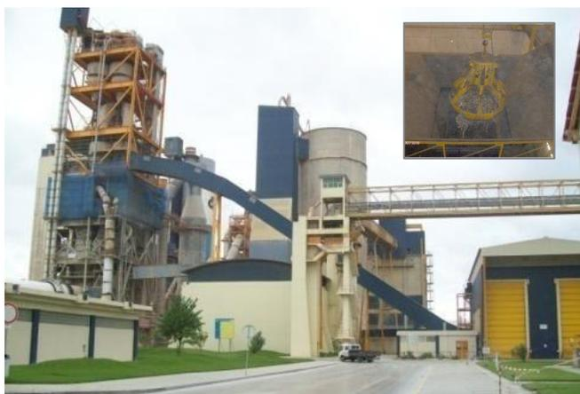
Armazém de combustíveis alternativos, à direita, com alimentação através de transportador fechado (MTD 14.e) para coprocessamento (MTD 7.e e MTD 12) no pré-calcinador do forno 7 localizado na torre de ciclones, à esquerda, de pré-aquecimento em 5 etapas (MTD 6.2a), a qual dispõe na etapa 1 de 2 ciclones de alta eficiência (MTD 7.a7+)
