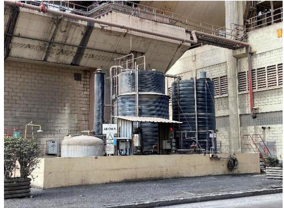
Depósitos da amónia utilizada na MTD 19.c), Redução não catalítica seletiva – SNCR, para controlo das emissões de NOx nas chaminés dos fornos 6 e 7
