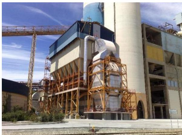
Filtro de mangas, à esquerda, de despoeiramento dos gases do forno 6, instalado desde 2002 (MTD 17.b)
