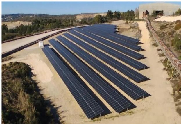
Nova Central Fotovoltaica para Autoconsumo (UPAC), com potência de 1 MW e área de implantação de 11 490 m<sup>2</sup>
