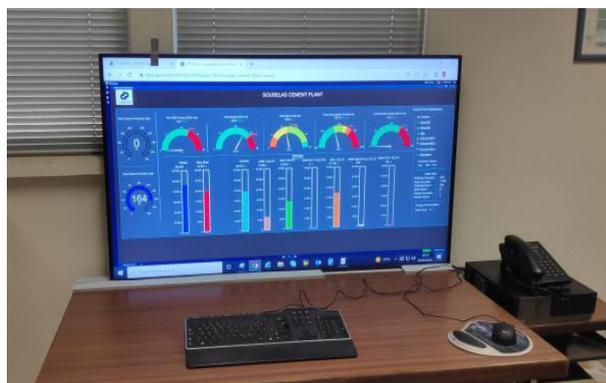
Imagem do novo software/sistema de inteligência operacional com tecnologia OSIsoft, suportando a implementação dos princípios da Indústria 4.0 ao nível da eficiência de processos
