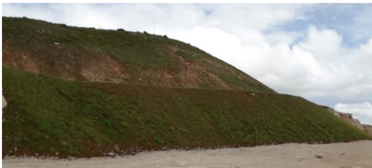
Talude revegetados: Área M do Piso 10 (talude inferior em curso) e Área F do Talude Norte (talude superior considerado recuperado)
