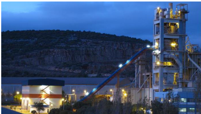
Armazém de combustíveis alternativos, à esquerda, com alimentação através de transportador fechado (MTD 14.e) para coprocessamento (MTD 7.e e MTD 12) no pré-calcinador do forno; Torre de ciclones de pré-aquecimento em 4 etapas (MTD 6.2), à direita.
