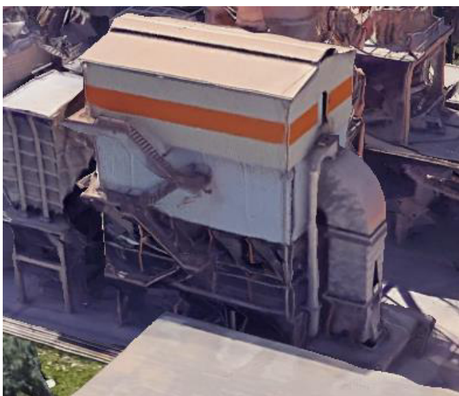
Filtro de mangas de despoejamento dos gases do forno em funcionamento desde 2002 (MTD 17.b).
