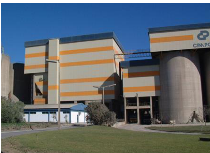
Cobertura/fecho do Edifício da Moagem de Cimento (à esquerda), do Carregamento a Granel (ao centro) e dos Silos de Cimento (à direita), existentes desde 2002 (MTD 14.b)
