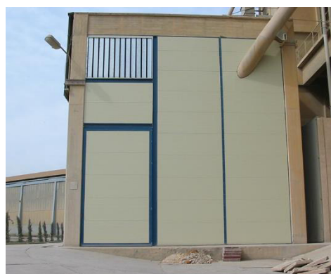
Isolamento acústico do edifício da moagem de cru realizado em 2004 (MTD 2).
