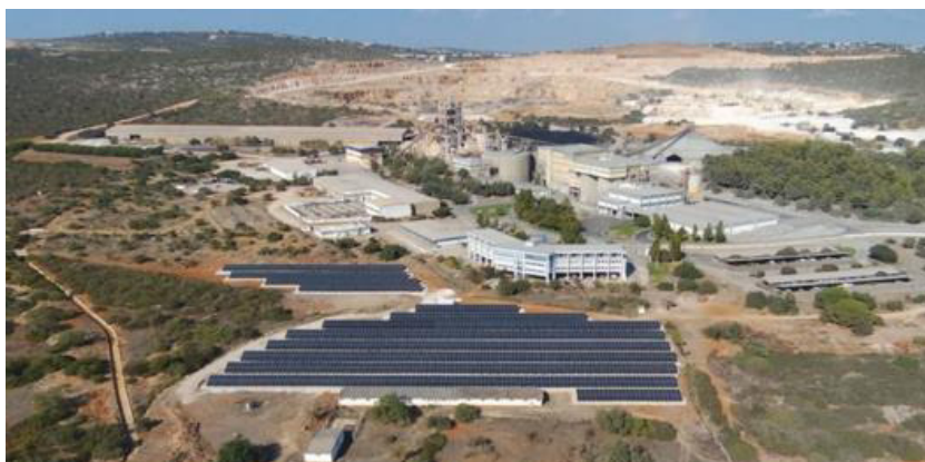
Nova Central Fotovoltaica para Autoconsumo (UPAC)
