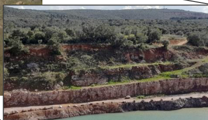
Talude Sul (ampliação)
