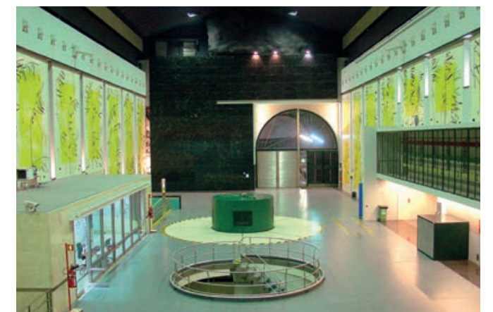
Frades - Sala de Máquinas
