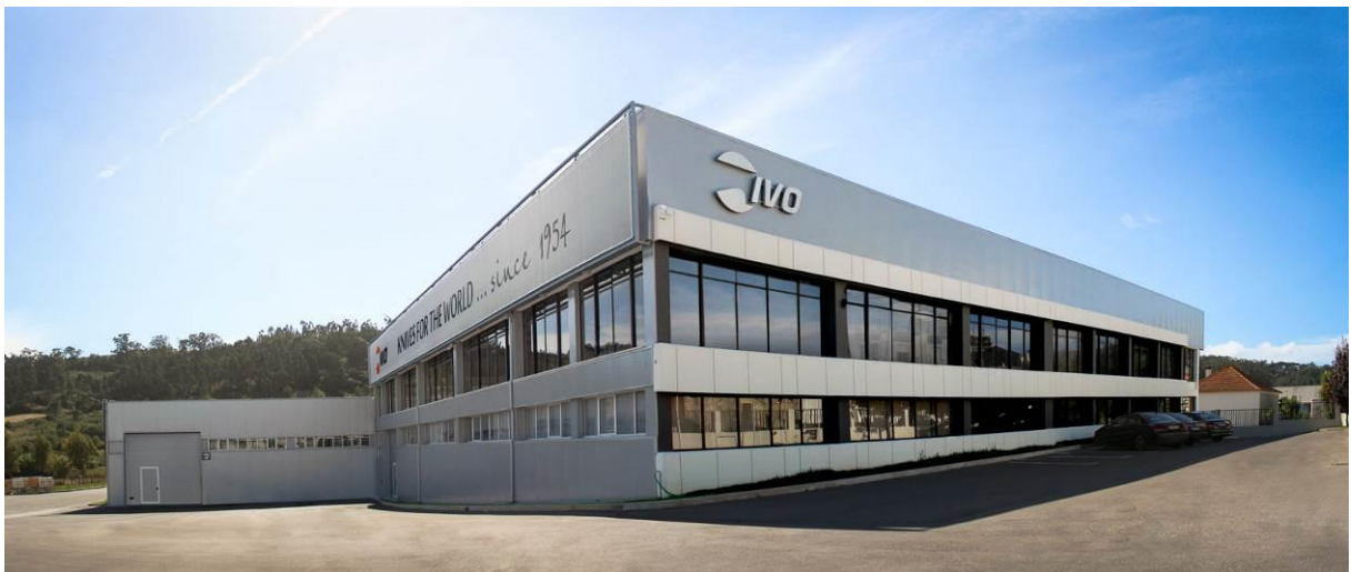
Figura 1 - Fachada da empresa.
