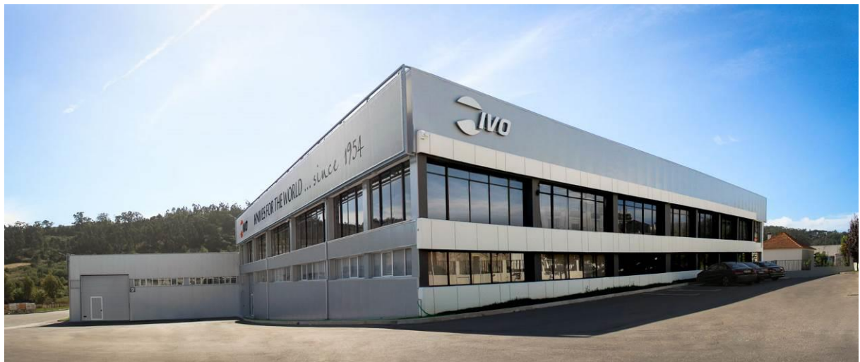
Figura 1 - Fachada da empresa.
